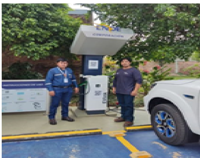
AETN verifica sistema de recarga para vehículos eléctricos en Yapacani
